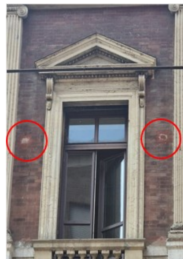
Finestra del primo piano dell'edificio storico del Dipartimento di Fisica di Torino, a cui era ancorata la capannina meteorologica dell'Osservatorio. I segni degli ancoraggi, cerchiati in rosso, sono ben visibili sulla finestra centrale della facciata nord.
