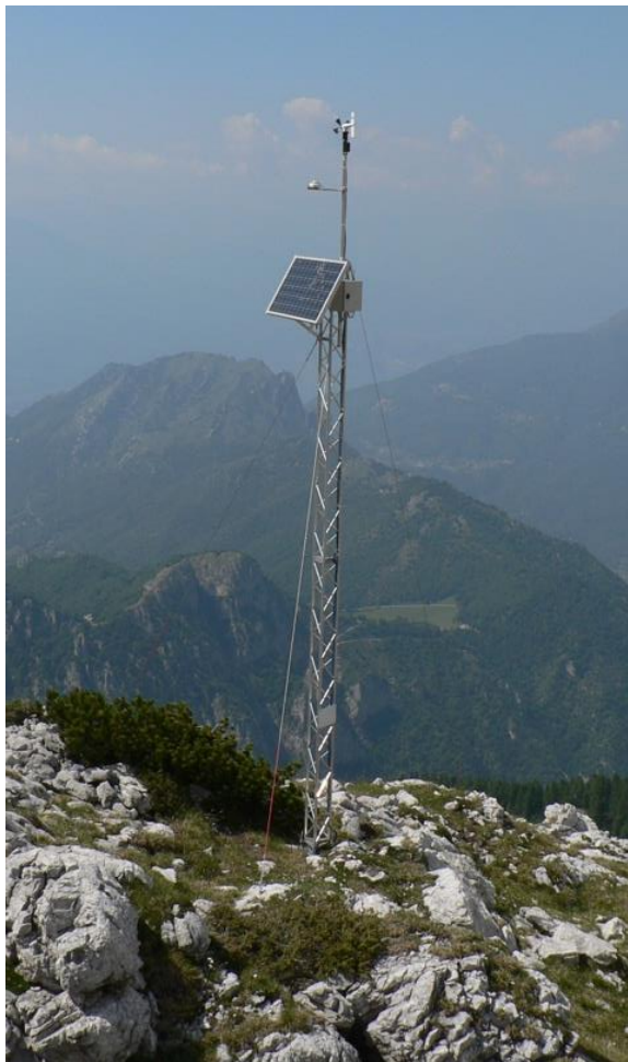
Figura 6. Particolare della stazione "meteorologica" presso l'imbocco della LO LC 1650.
